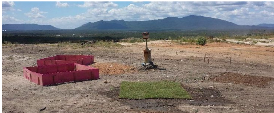
Figura 35 Montagem das camadas sobrepostas à camada original de cobertura
