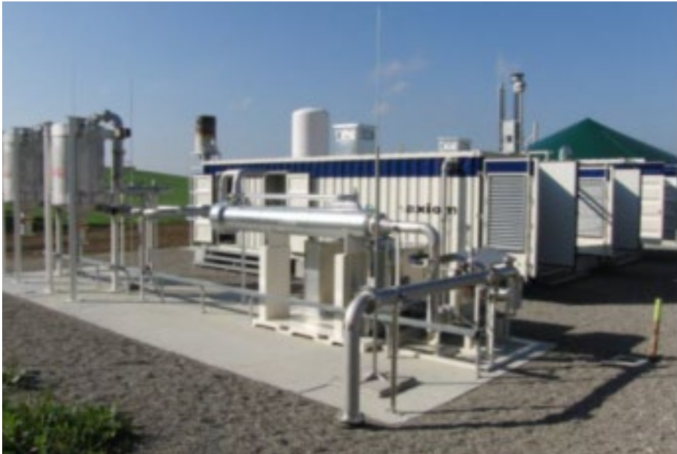
Figura 65 Unidade típica de enriquecimento de biogás com membranas: usina de Kisslegg (Alemanha) com capacidade de 500 m 3 /h.
