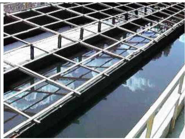
Figura 7.12 – Tanque de contato com regime de escoamento de fluxo pistão (ETE Caçadores – Cambé/PR)
