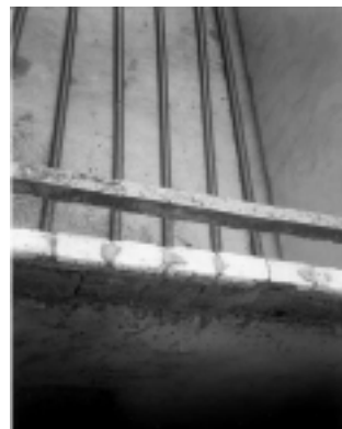
Fig. 4.29 – Dispositivo de distribuição de esgotos no fundo do um filtro anaeróbio (ETE piloto da UFRN- vazão: 30 L/s)
