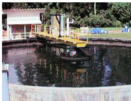
Figura 4.15 - Decantador secundário pós FBP (ETE Caçadores – Cambé/PR)
