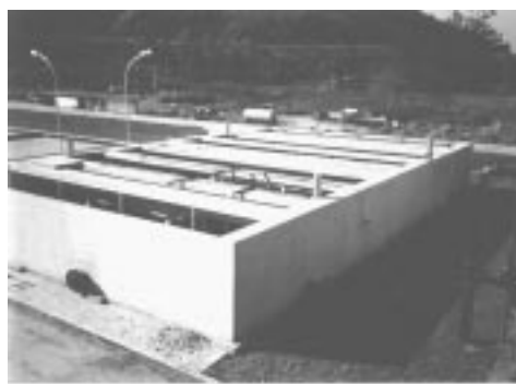
Fig. 4.27 - Filtro anaeróbio pós reator UASB (ETE Rio Doce - Ipatinga/MG – vazão de cada filtro: 40 L/s)
