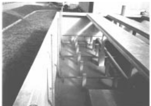
Fig. 4.28 – Dispositivo de distribuição de esgotos no fundo do um filtro anaeróbio (ETE Rio Doce - Ipatinga/MG – vazão de cada filtro: 40 L/s)
