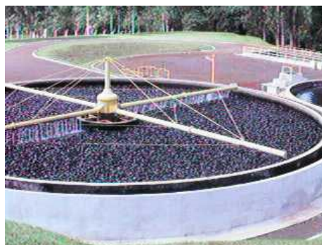
Fig. 4.11 - Sistema rotatório de distribuição no FBP (ETE Caçadores – Cambé/PR)
