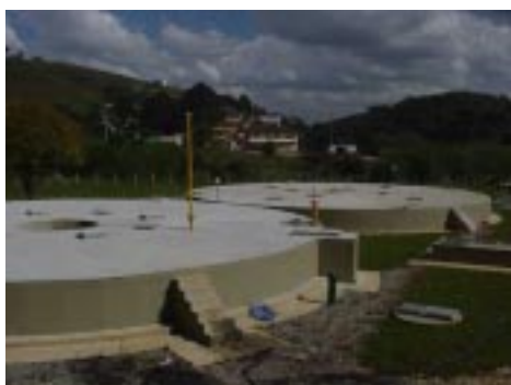
Fig. 4.26 – Filtro anaeróbio pós reator RALF (ETE Colombo/PR - vazão 30 L/s)
