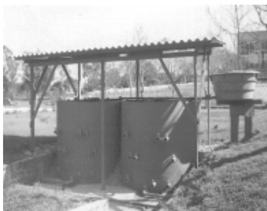
Figura 2 - Bacias de Infiltração Rápida em Solo Arenoso Integrantes da Instalação Piloto
