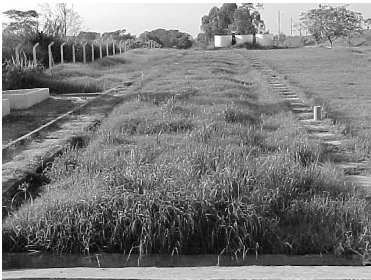
Figura 1 - Vista geral da rampa do sistema de pós-tratamento por escoamento superficial de efluente anaeróbio
