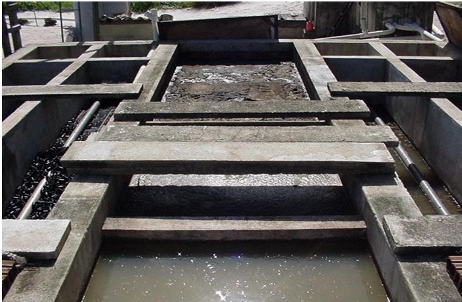
Figura 1 – O sistema piloto da UFRN, tanque séptico seguido de filtros anaeróbios
